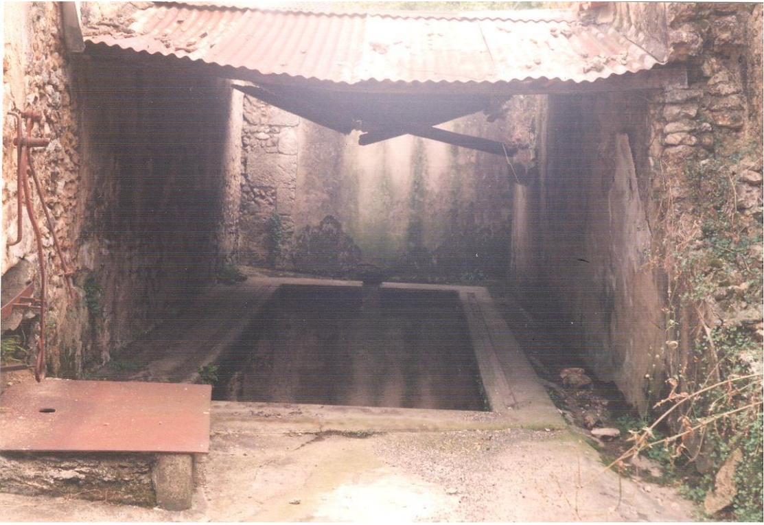
Lavoir avant restauration
