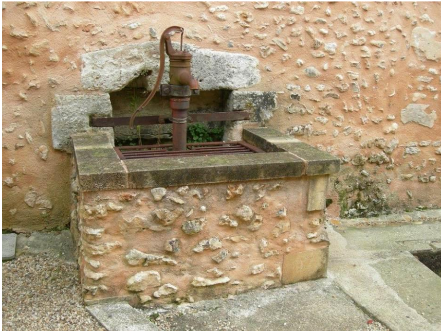
Regard et pompe manuelle
