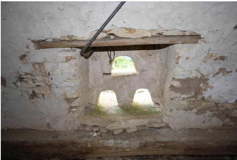
Lucarne d'envol vue de l'intérieur du pigeonnier
