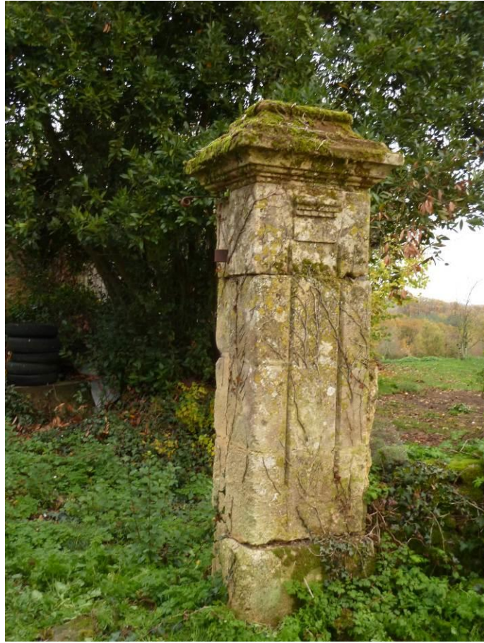
Pilier droit cour grange
