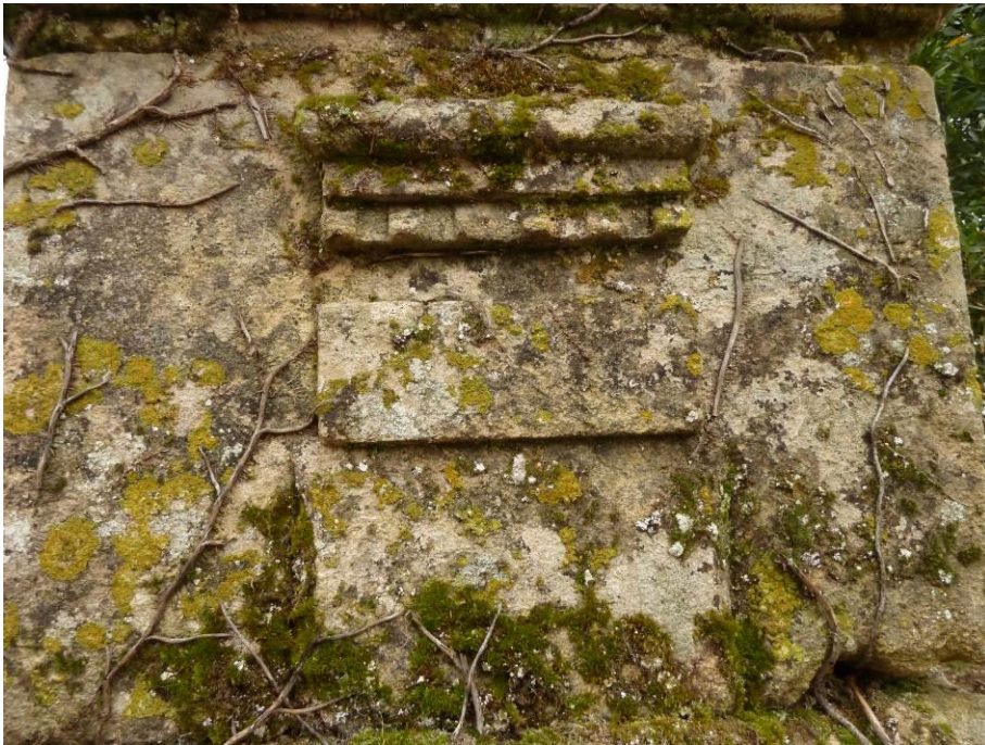
Détail pilier droit cour grange
