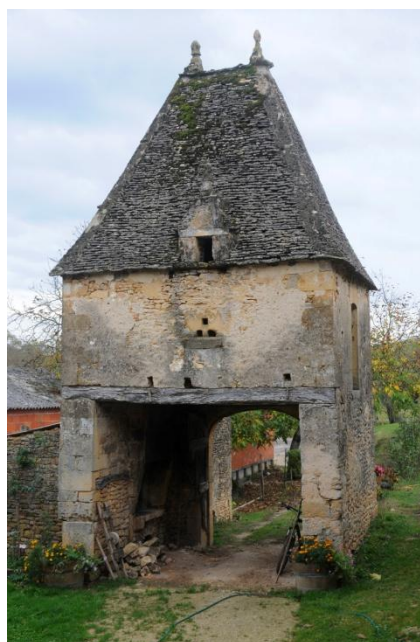
façade Nord Ouest
