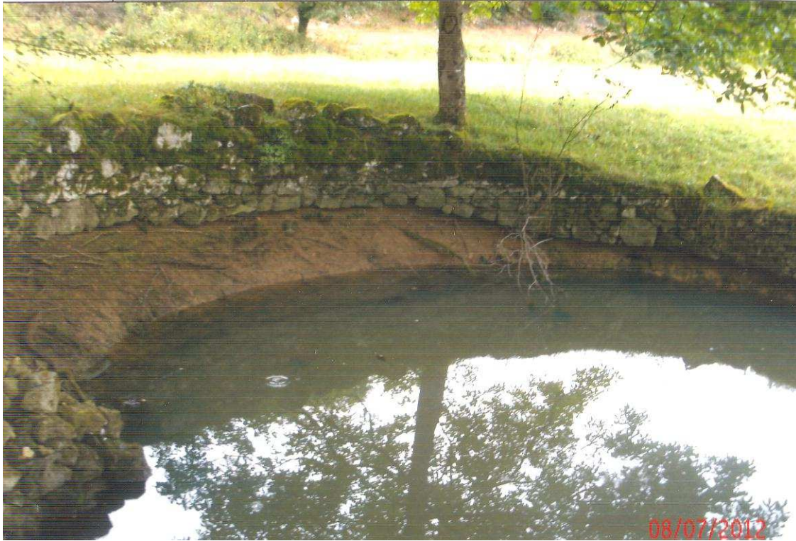
Partie ouest du réservoir
