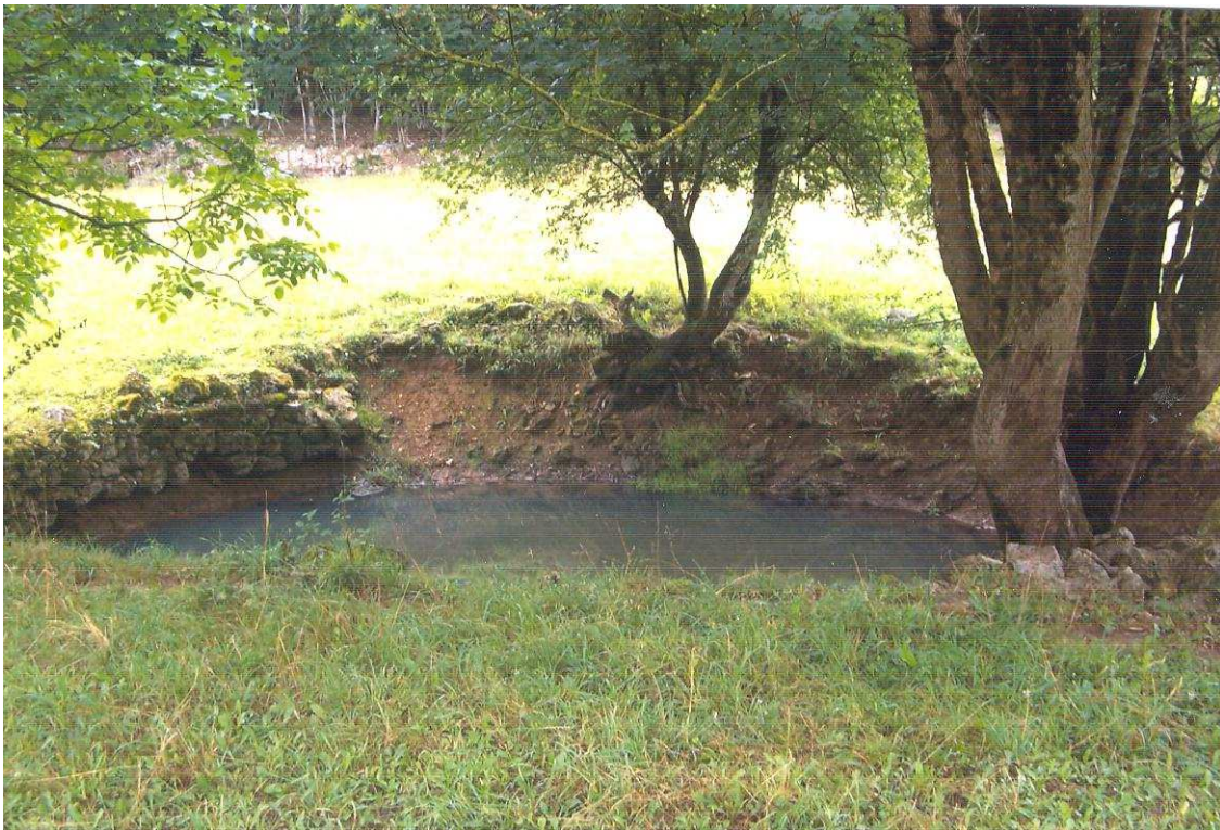
Vue générale du réservoir au milieu d'un pré. Des arbres ont poussé sur ses bords, ruinant l'entourage en moellons.
