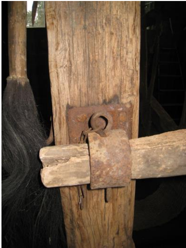
Goupille d'immobilisation de la barre arrière
