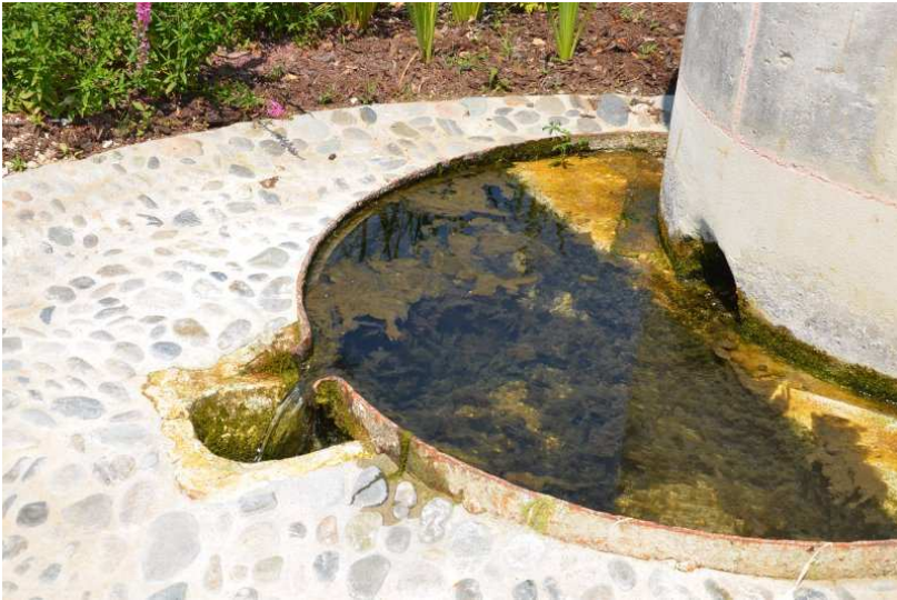
Le déversoir vers le lavoir
