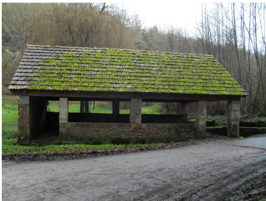
Vue Sud Ouest
