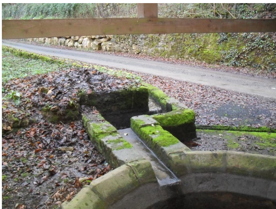
Détails sur les rigoles d'alimentation
