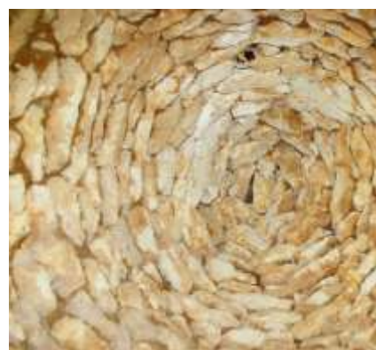
voûte de la partie inférieure
