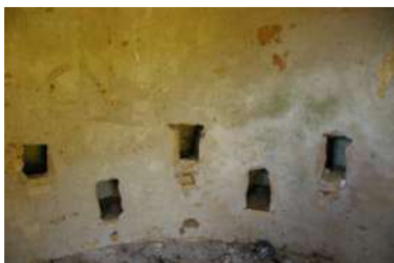
Boulins de la partie supérieure
