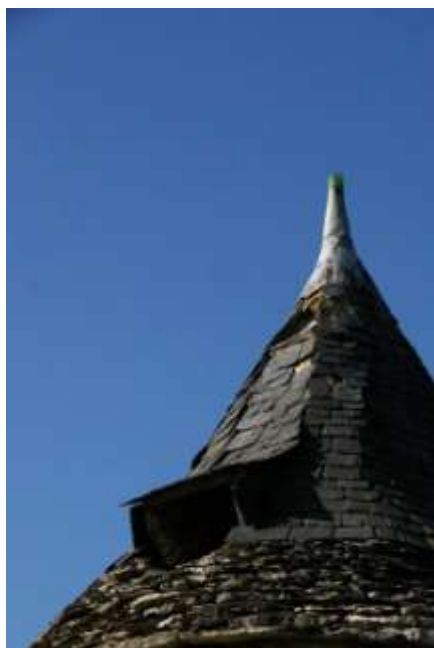
Détail de la toiture
