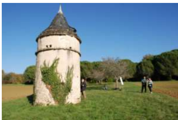
Façade Sud Ouest
