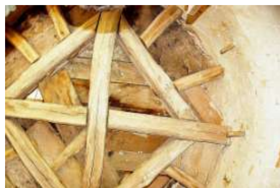
enrayure de la charpente
