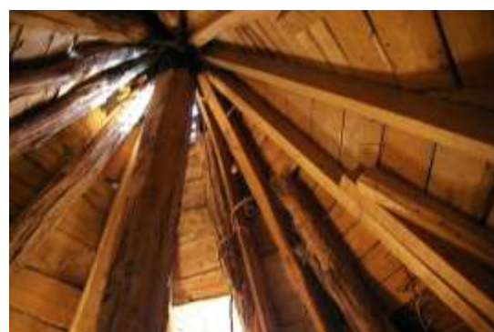
enrayure de la charpente
