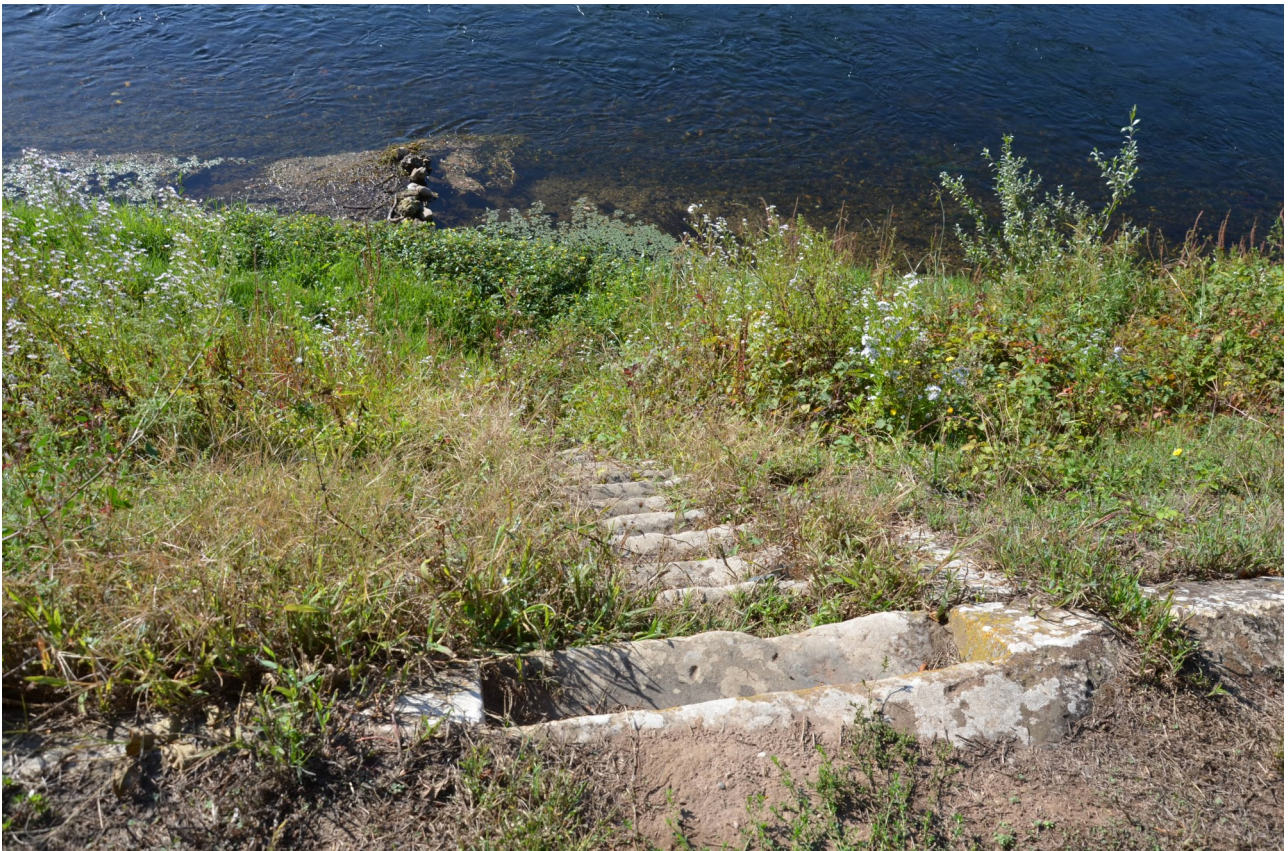
L'escalier donnant accès à la plage
