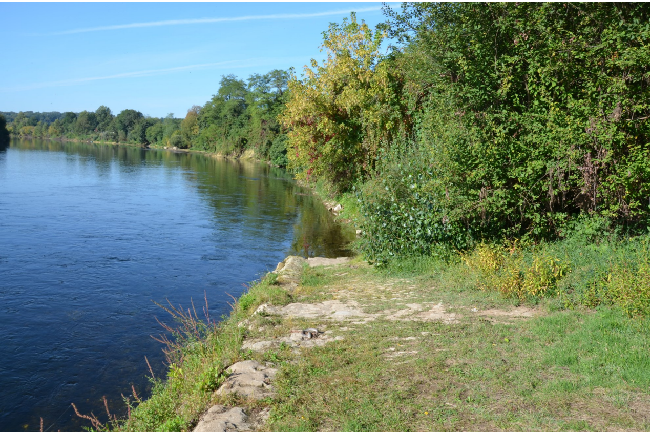
Détail du quai
