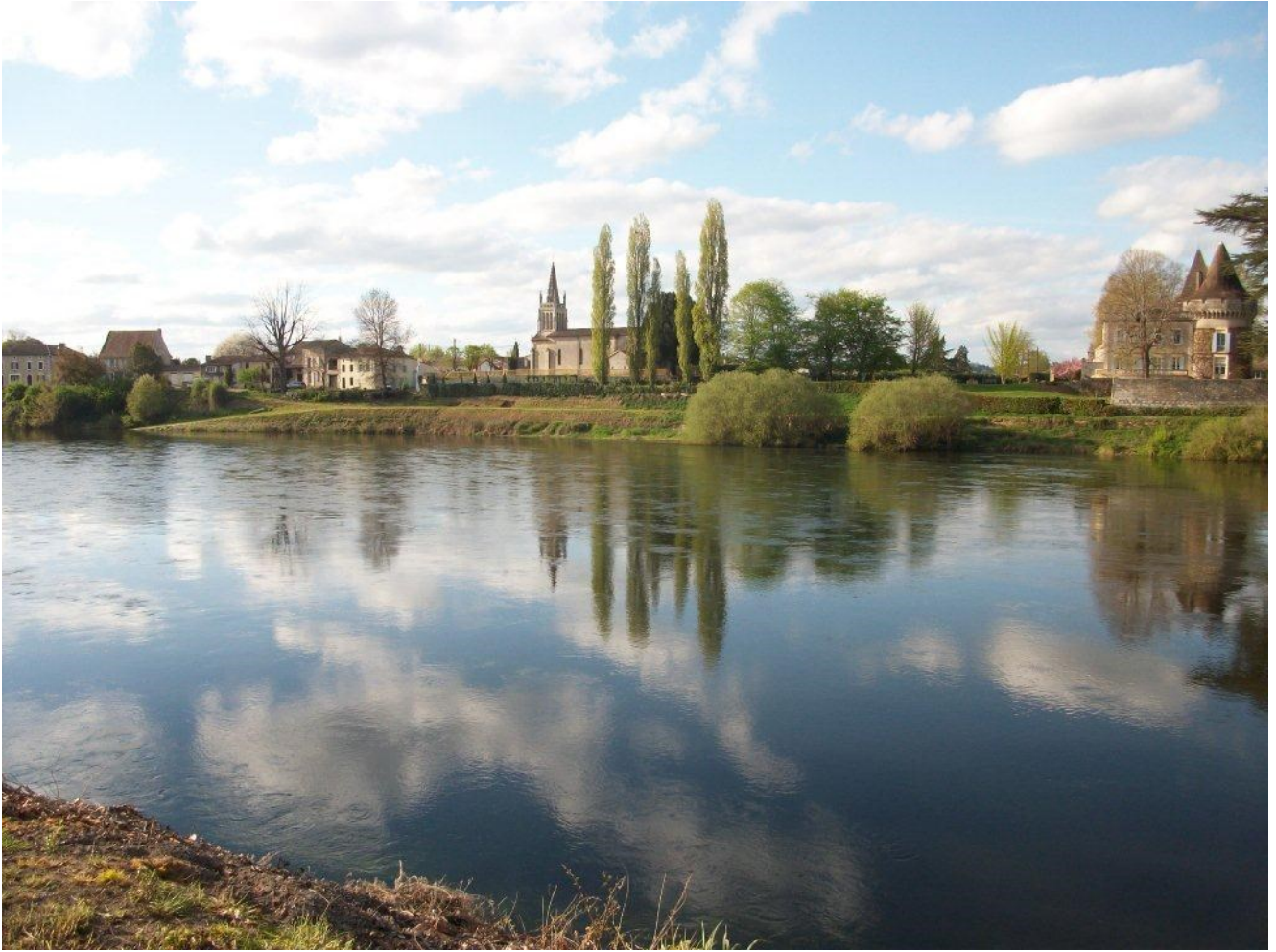
Le port aujourd'hui, vu de la rive gauche
