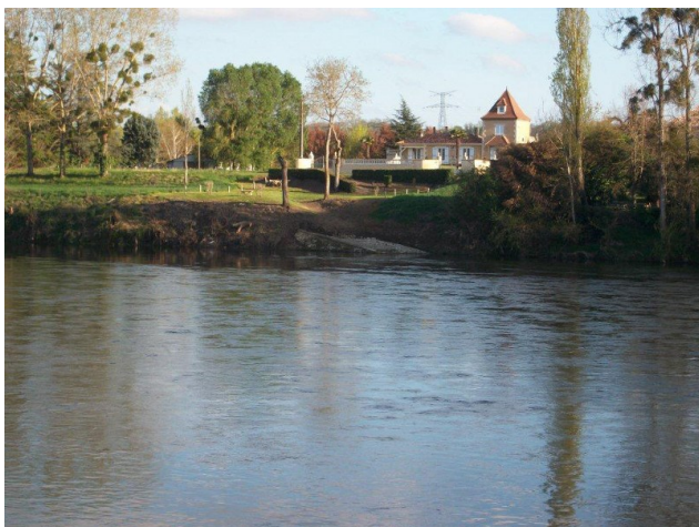
La cale d'accostage du bac sur la rive opposée, commune d'Eynesse, en Gironde
