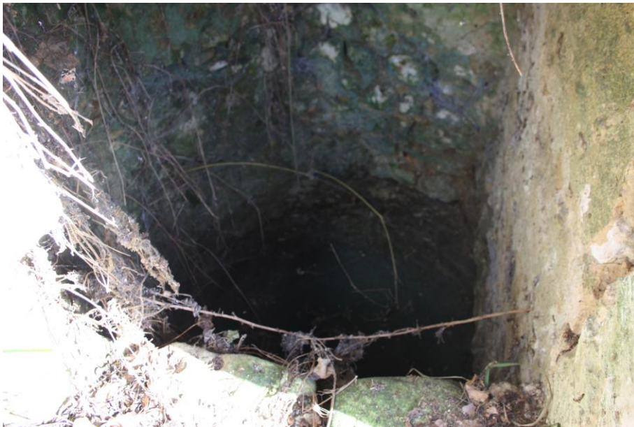
Intérieur de l'ouvrage
