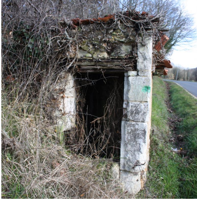
Entrée du puits
