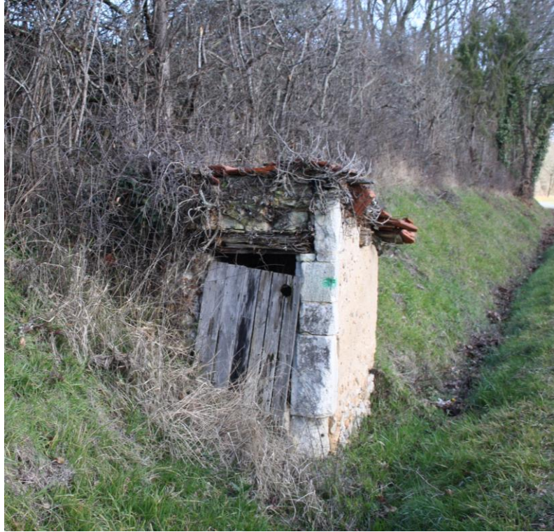
Façade principale est
