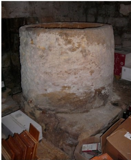
« BUJADIER » EN PIERRE TAILLEE INTERIEUR AVEC BONDE
