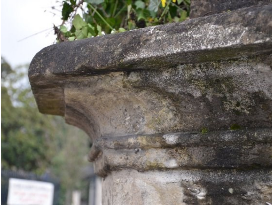
Détail de la corniche
