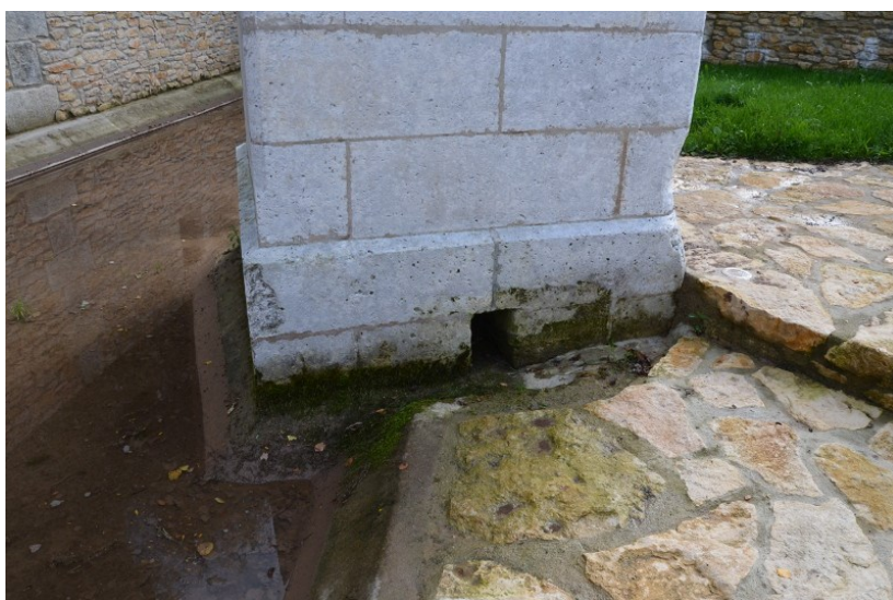
Déversoir de la fontaine dans le lavoir
