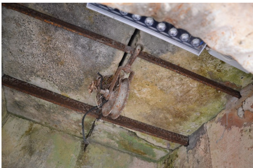
Barres de fer soutenant les dalles du toit et poulie
