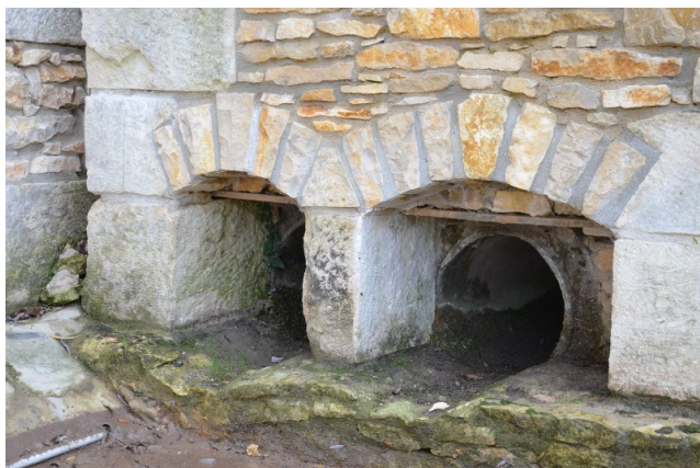
Arrivée de l'eau côté sud
