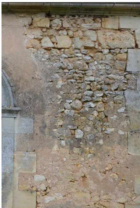
Détail du bâti
