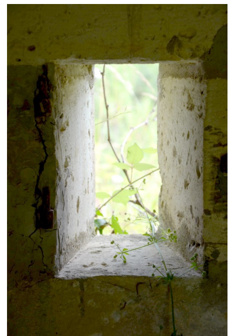
L'une des fenêtres vue de l'intérieur
