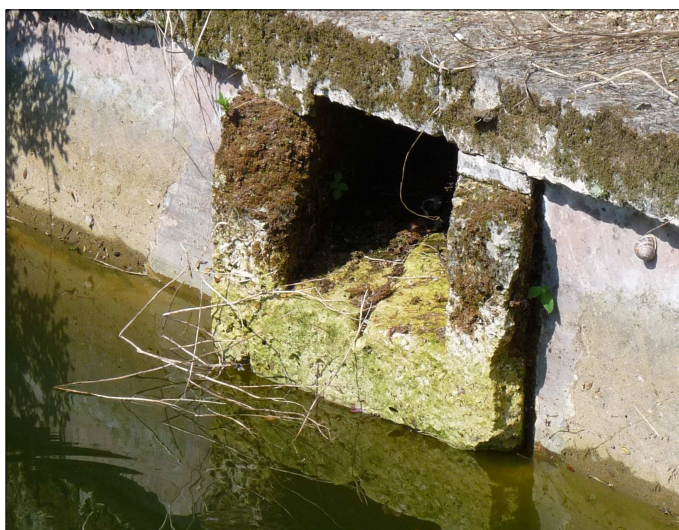
Détail de l'aqueduc d'alimentation de la citerne découverte
