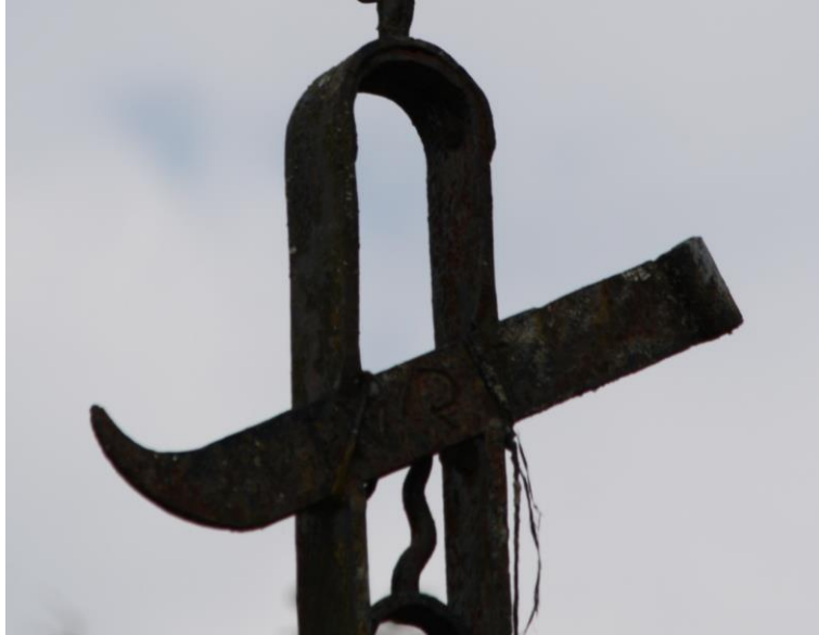
Titulus gravée I N R I et raccordement des deux parties de la croix à son sommet
