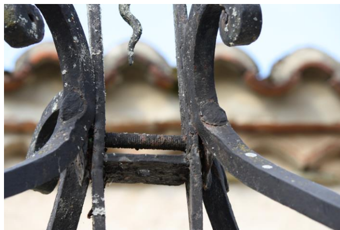
Vis boulonnée serrant les plaques sur les montants de la croix et entretoise
