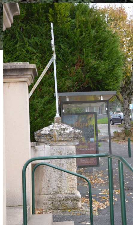
Vue de côté (ouest-sud-ouest)
