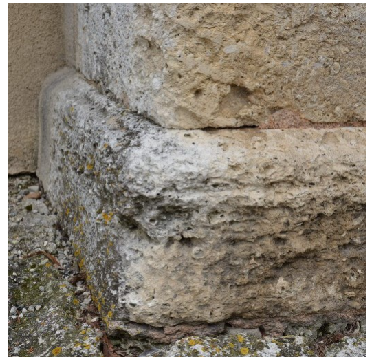
Base du piédestal
