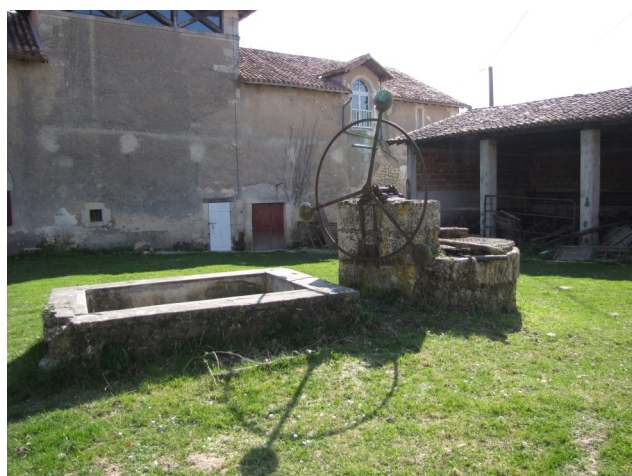
3 - Un dispositif assez différent à Saint-Astier, au lieu-dit Puyferrat. Pas de bielle cette fois et la roue est orientée différemment.
