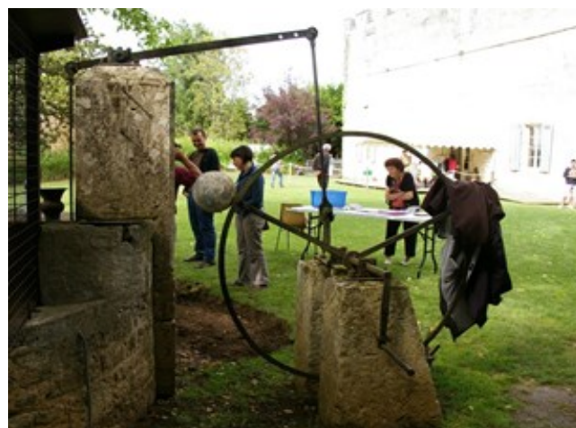
4 - Un autre puits en état de marche, à Limeuil. Là encore la roue porte des masselottes.
