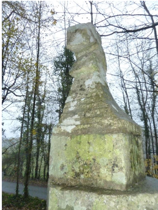
Vue de l'angle sud
