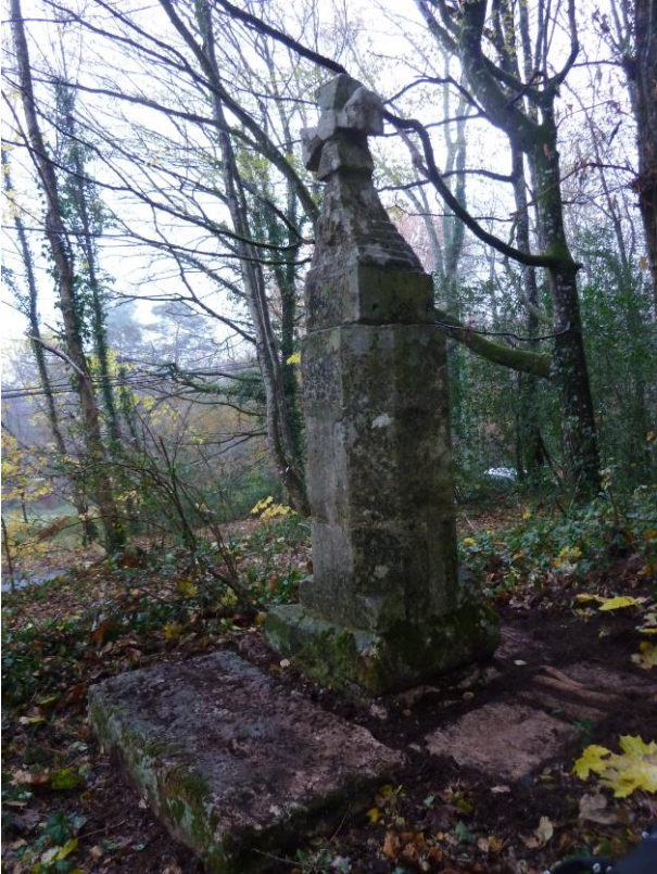
Vue de l'angle est
