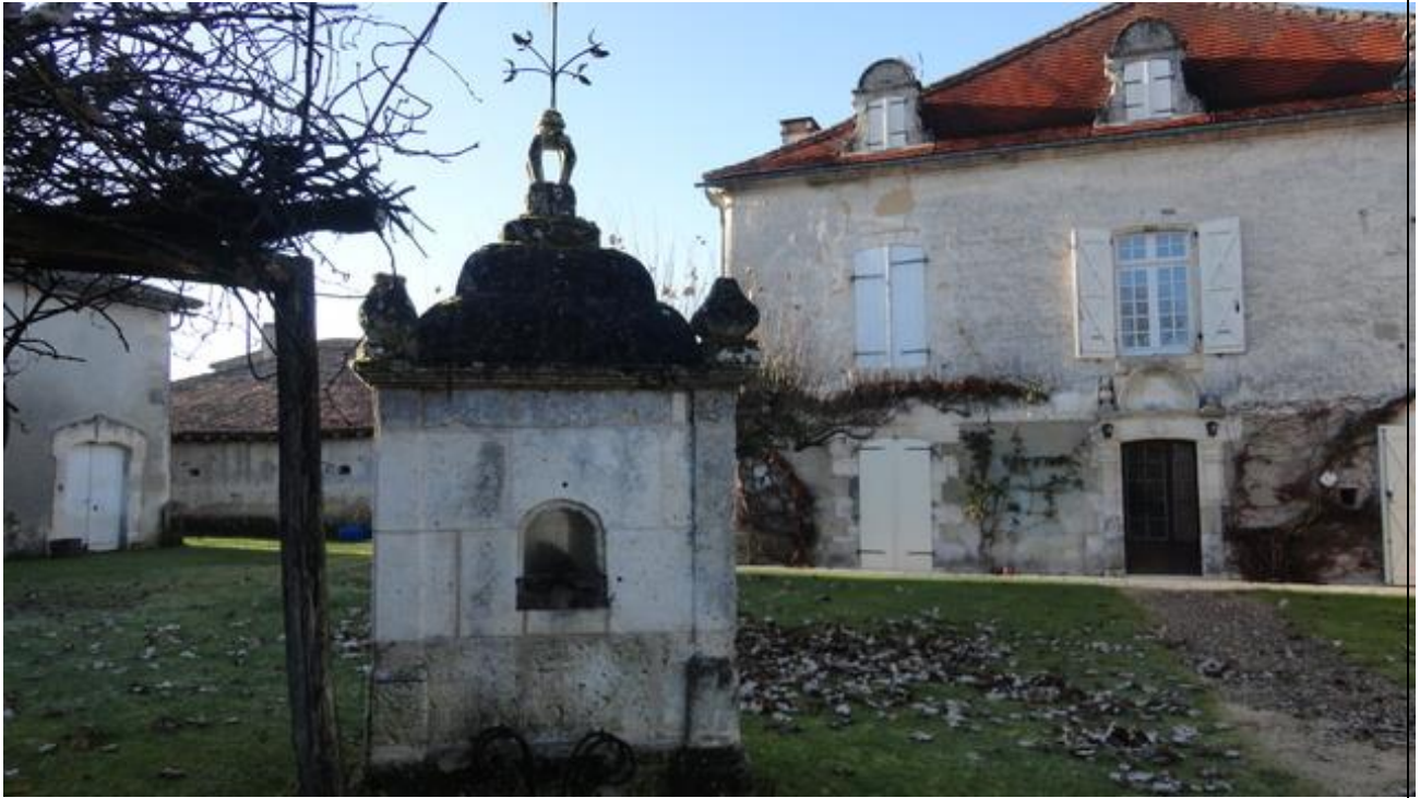
Vue de la cour intérieure
