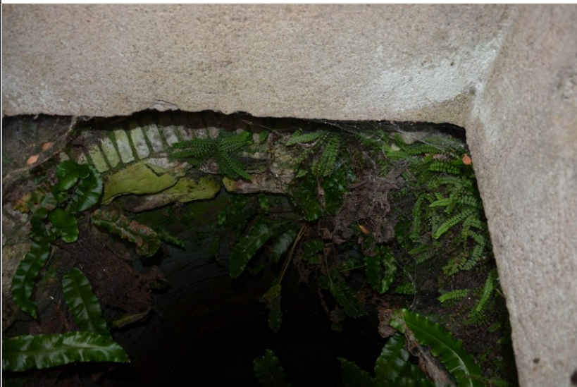
L'intérieur du puits, jonction entre béton et pierres
