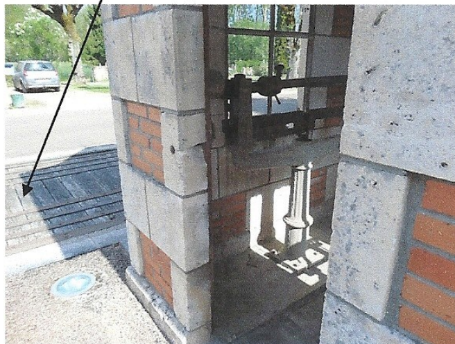
Entrée du local
