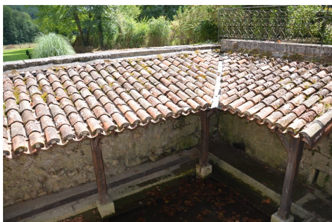
Vue sur la toiture depuis la place
