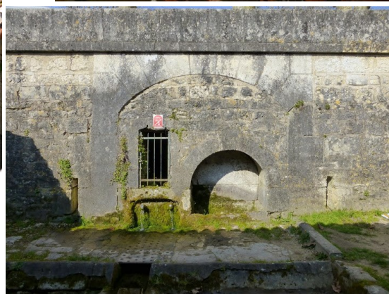
Le mur est
