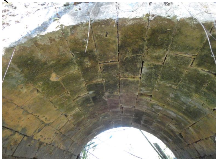
Vue d'ensemble du ponceau
