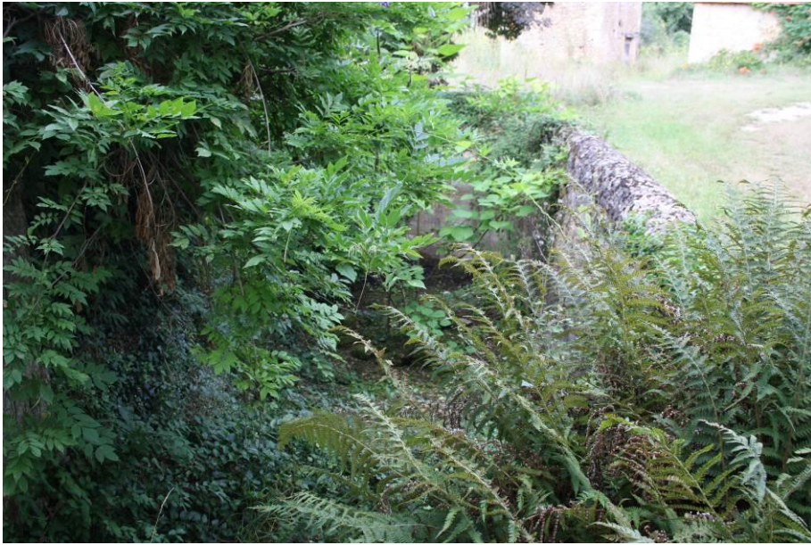
Paroi ouest vue de l'entrée
