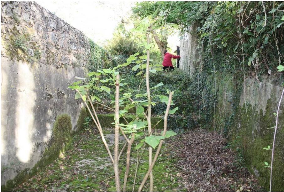
Vue de l'intérieur en direction de l'est
