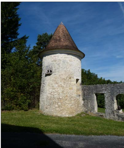
Pigeonnier-four à pain de la maison de maître
