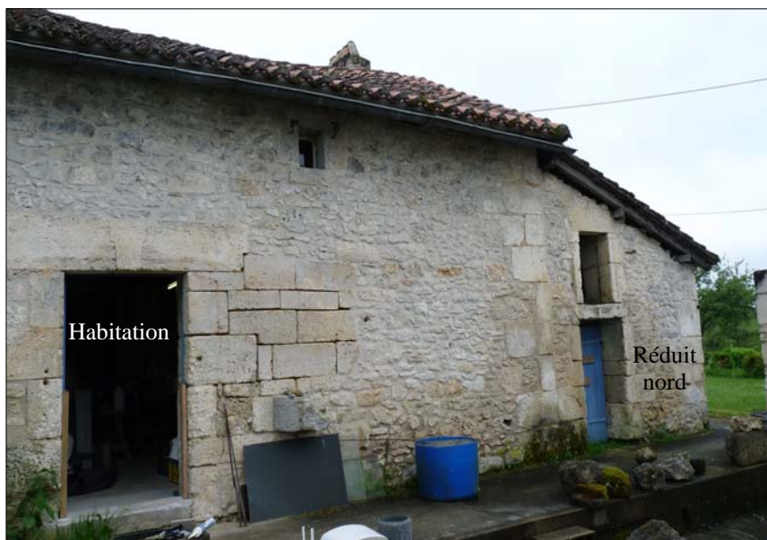
Façade Nord du bâtiment.
