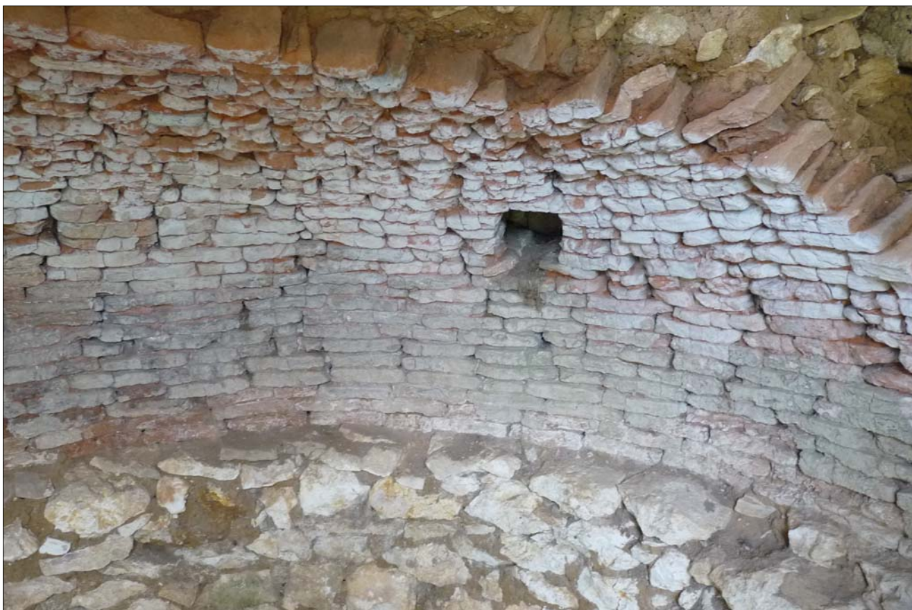
Détail du four à pain.
