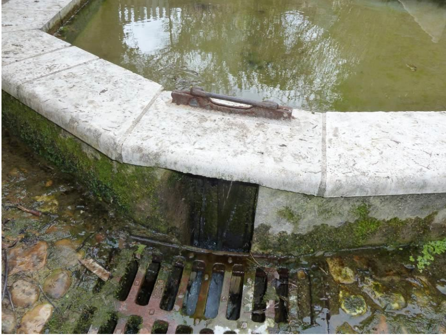
Trop plein et vidange réglables par vanne
