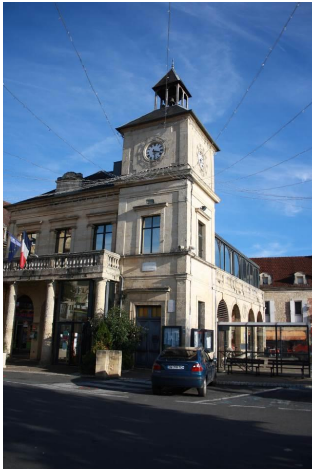
Angle sud-ouest vu de la Place de l'Hôtel de Ville
