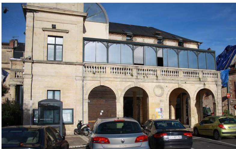
Façade sud (côté Vézère)
