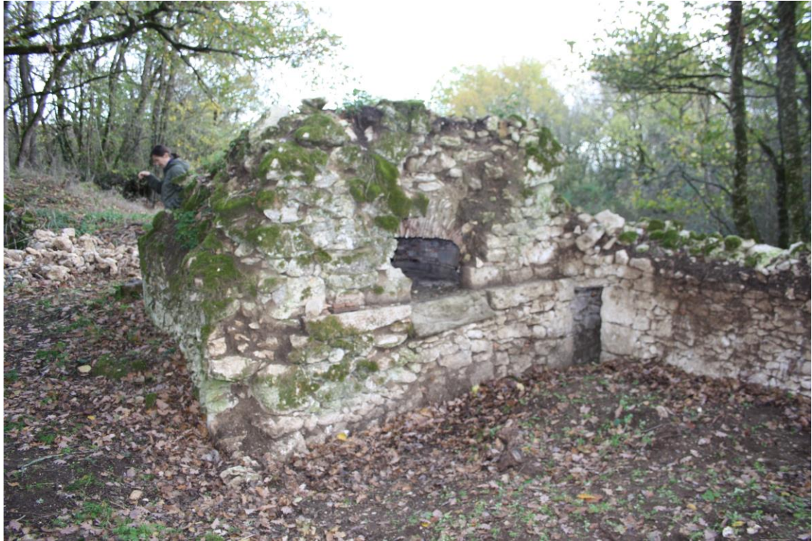
Vue d'ensemble après dégagement
