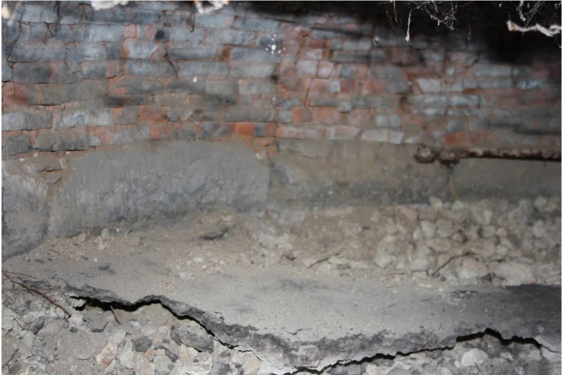
Vue intérieure avec sole ruinée et une partie du dispositif de calage des claies
