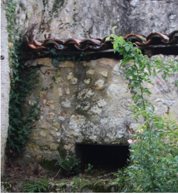
Désordres : à gauche, tuile d'égout trop courte, à droite, solin fissuré
