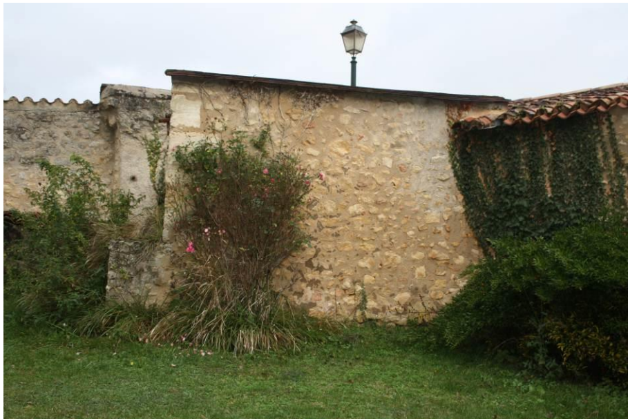
Vue de la façade sud
