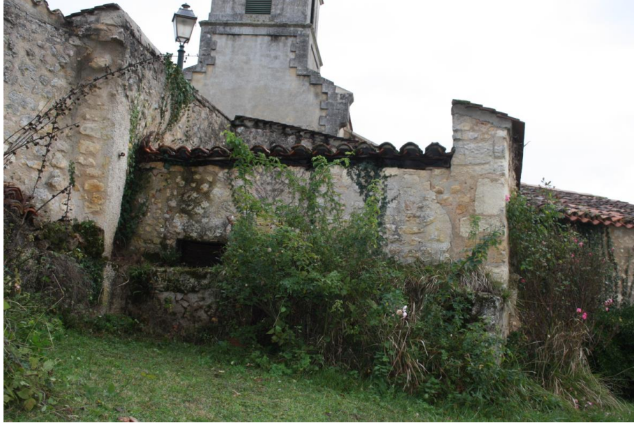
Vue d'ensemble de la façade (ouest)
