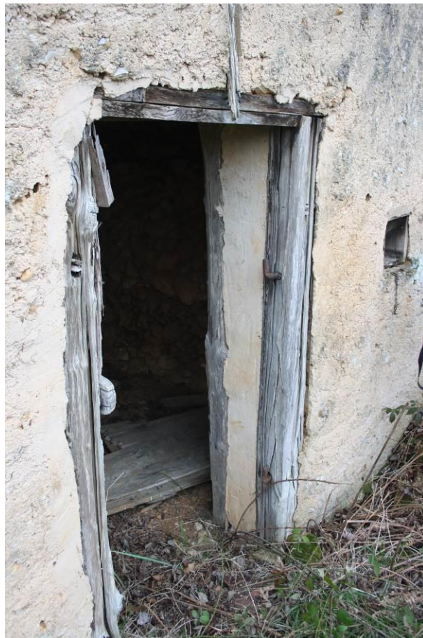
Entrée et fenestrou en façade
