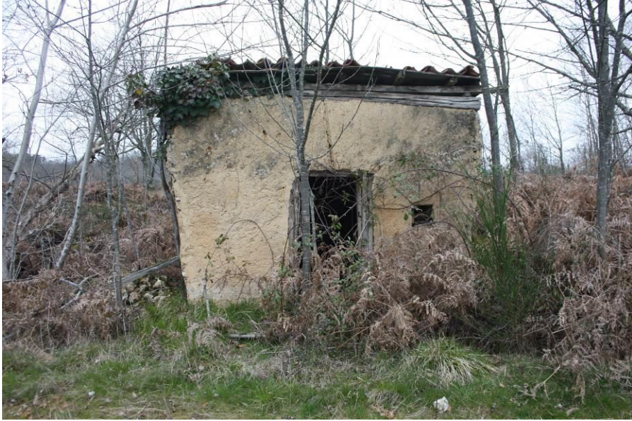
Façade principale (Est)
