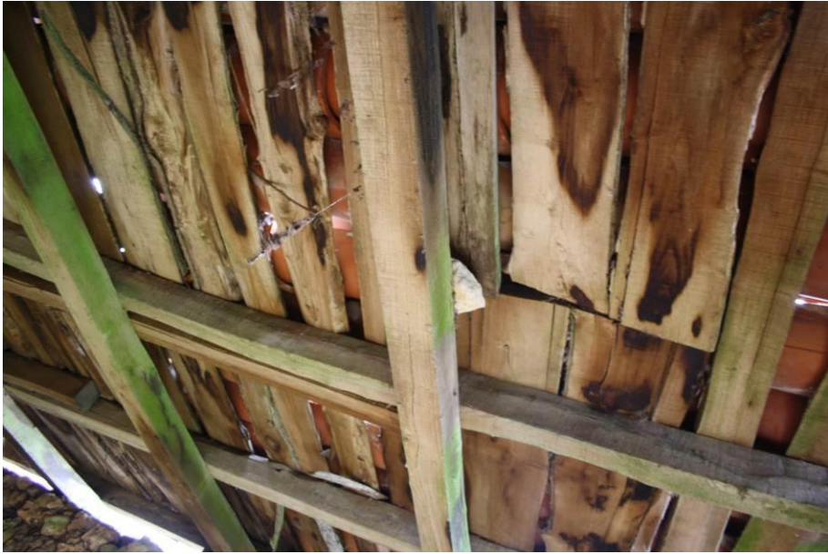
Sous toiture (Pannes, chevrons, voliges)
