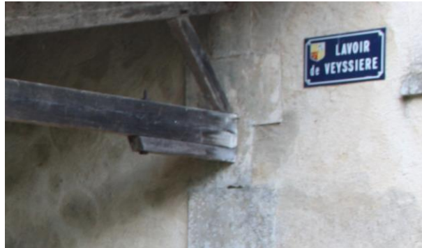
Encastrement des entrails renforcé par corbeau
