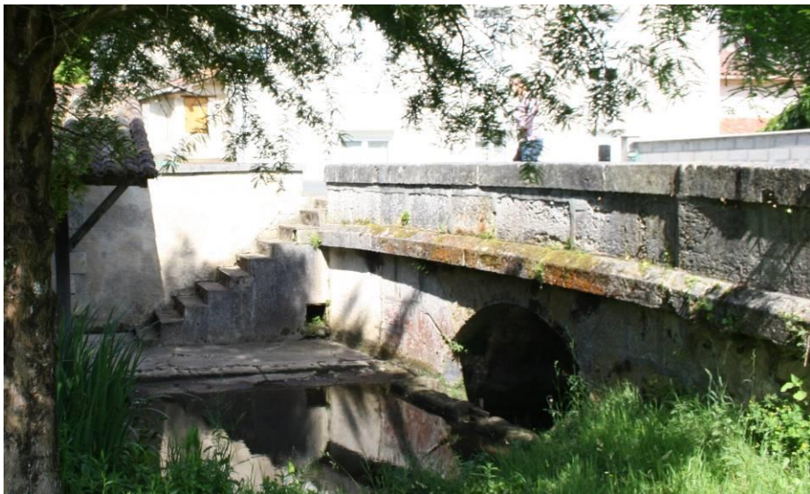
Vue de la rive droite
