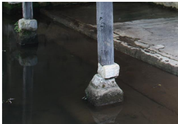
Pied des poteaux raccourci et calage provisoire
