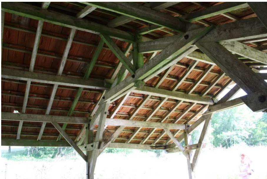
Charpente et couverture
