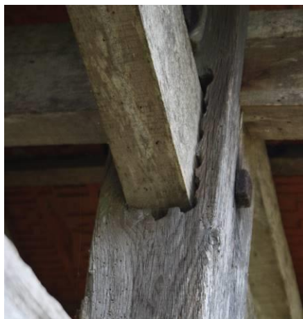
Mortaise réalisée à la perceuse (poteau sud-est)
