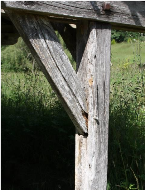
Poteau sud est
