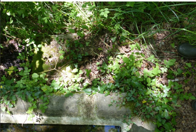
Le déversoir en juillet 2016
