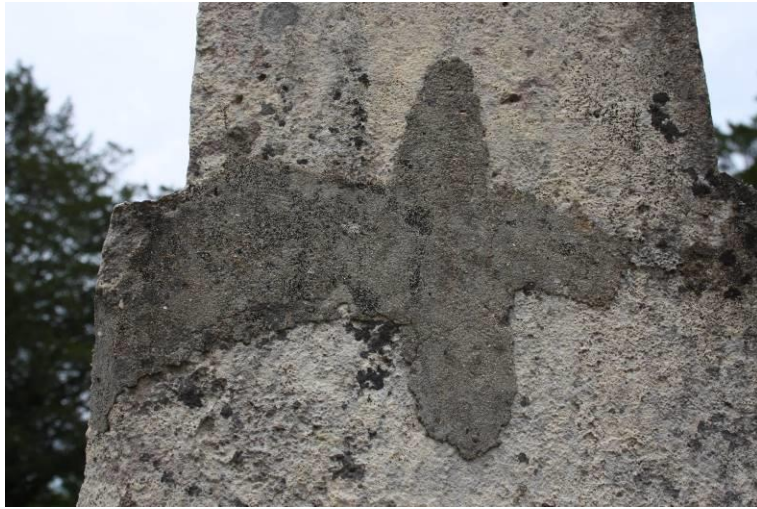
Réparation au ciment
