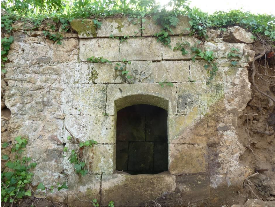
La fontaine en mai 2015 après dégagement et avant pose du portillon
