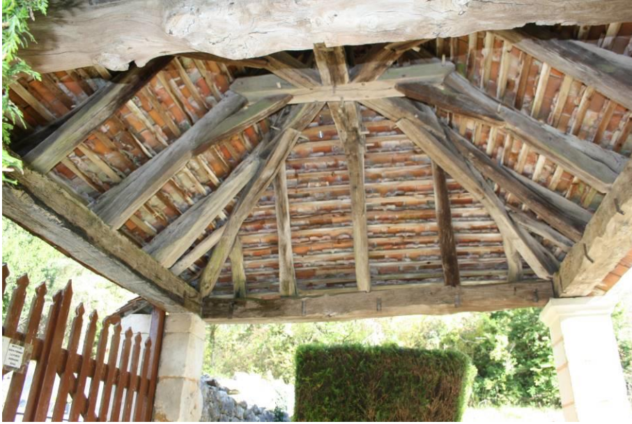
Charpente vue de l'ouest
