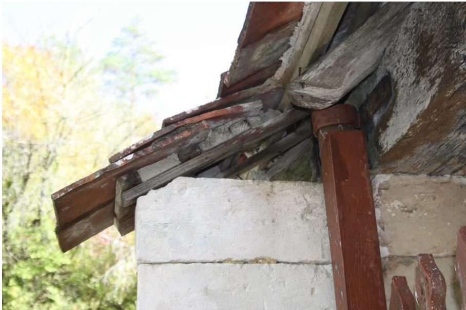
Palier supérieur du portail
