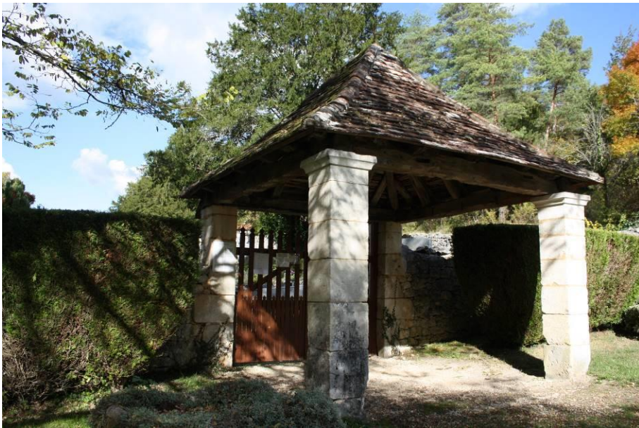
Vue du sud-ouest
