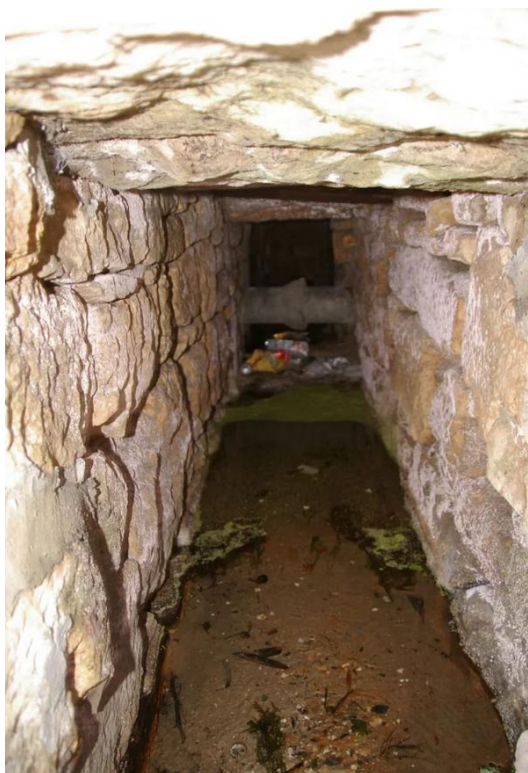
Aqueduc d'évacuation vers la Cuze
