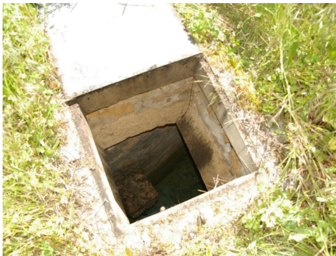
trappe d'accès à la citerne
