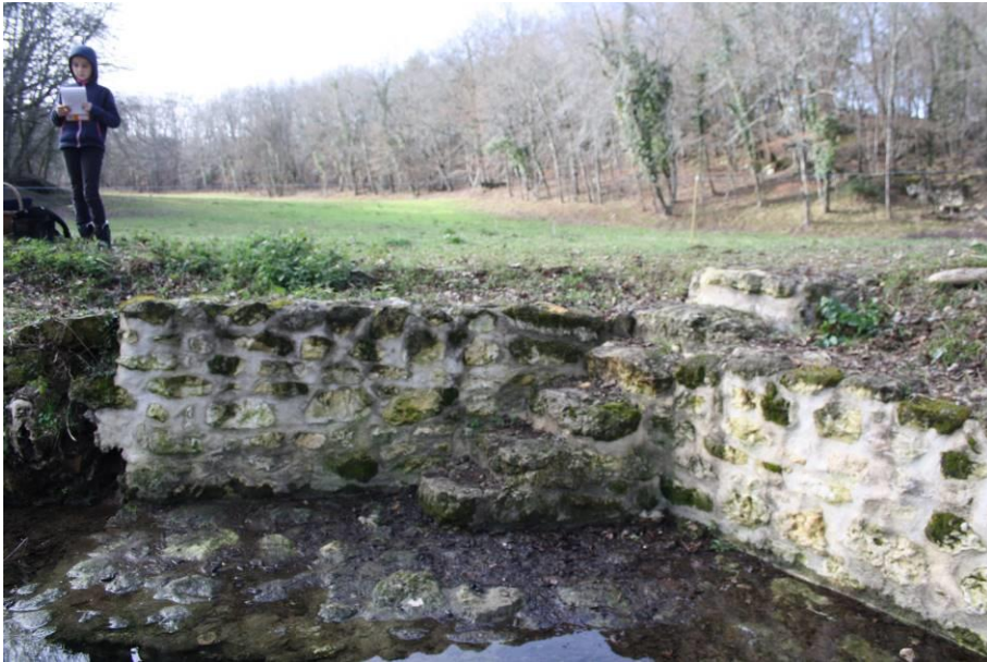
Escalier d'accès au lavoir (Vue en direction de l'Ouest, rive droite)
