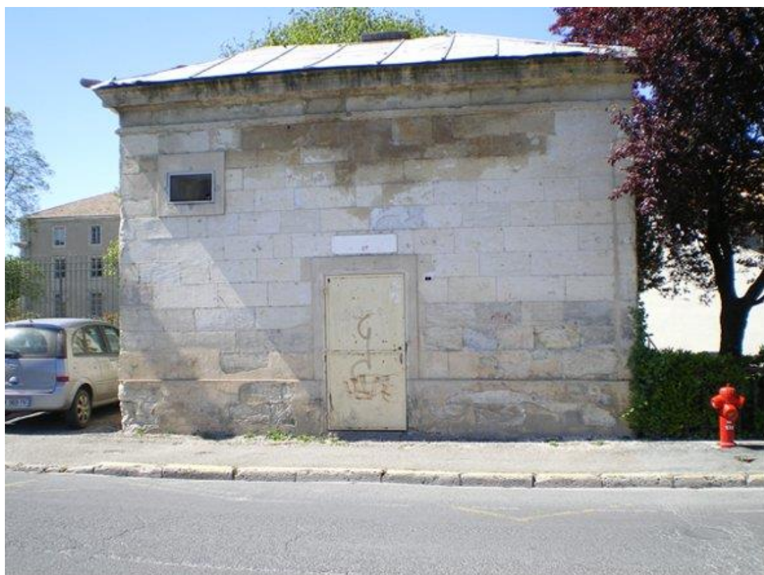
Face « est », donnant sur le boulevard Georges Saumande. Le toit est en zinc.
