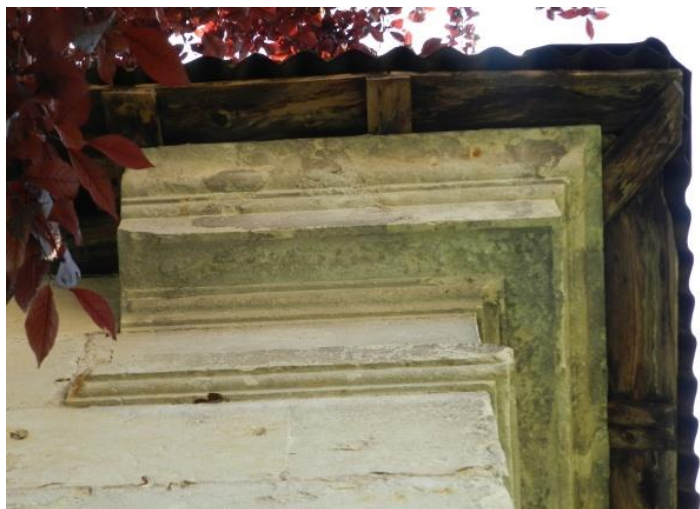
Extrémité de la corniche, face « ouest »
