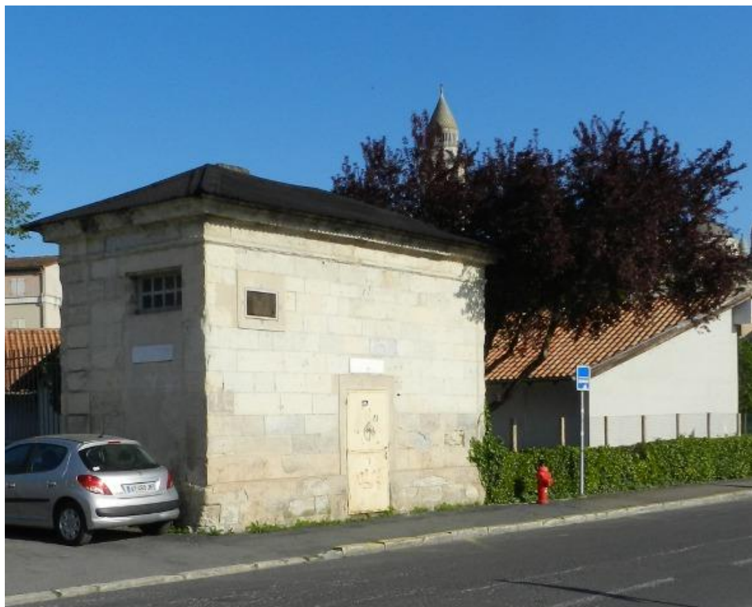
2018 : faces « sud » (dans l'ombre) et « est ». Le toit est en éverite.
