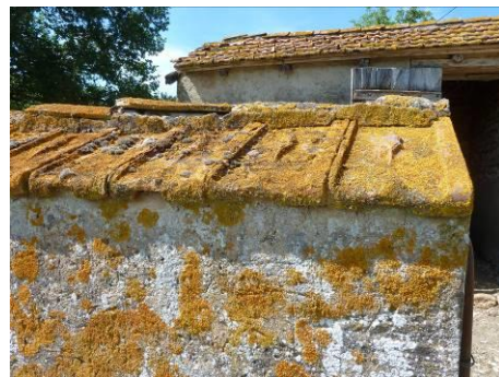
Chaperon du muret du parc gauche (sud)
