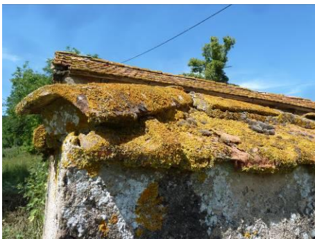
Chaperon du muret du parc (angle sud-est)
