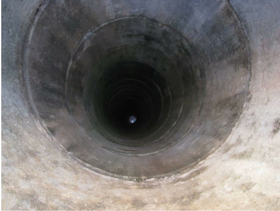
Intérieur du puits
