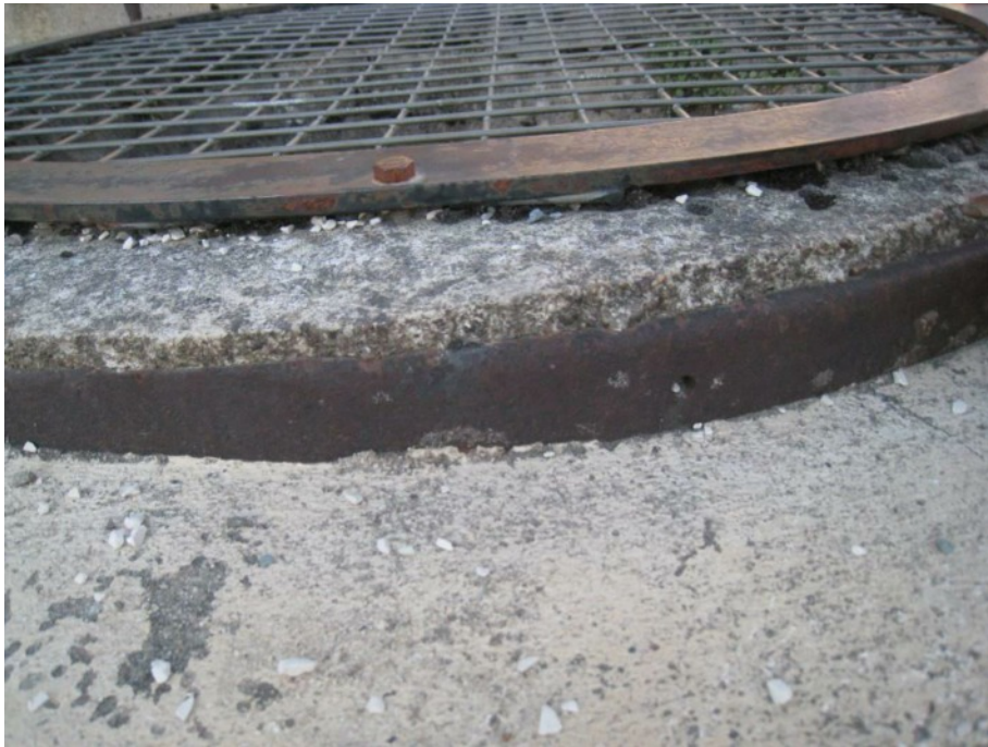
Cerclage de la buse et grille de sécurité
