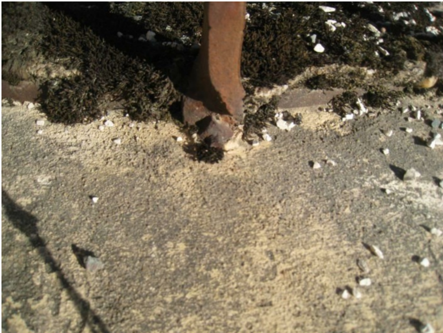
Scellement du portique du treuil
