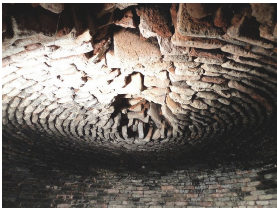
Vue intérieure du plafond du petit four
