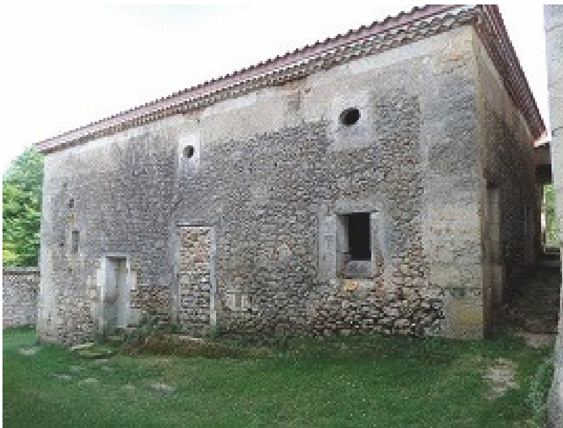
Façade Nord du bâtiment des fours et de la chaudière
