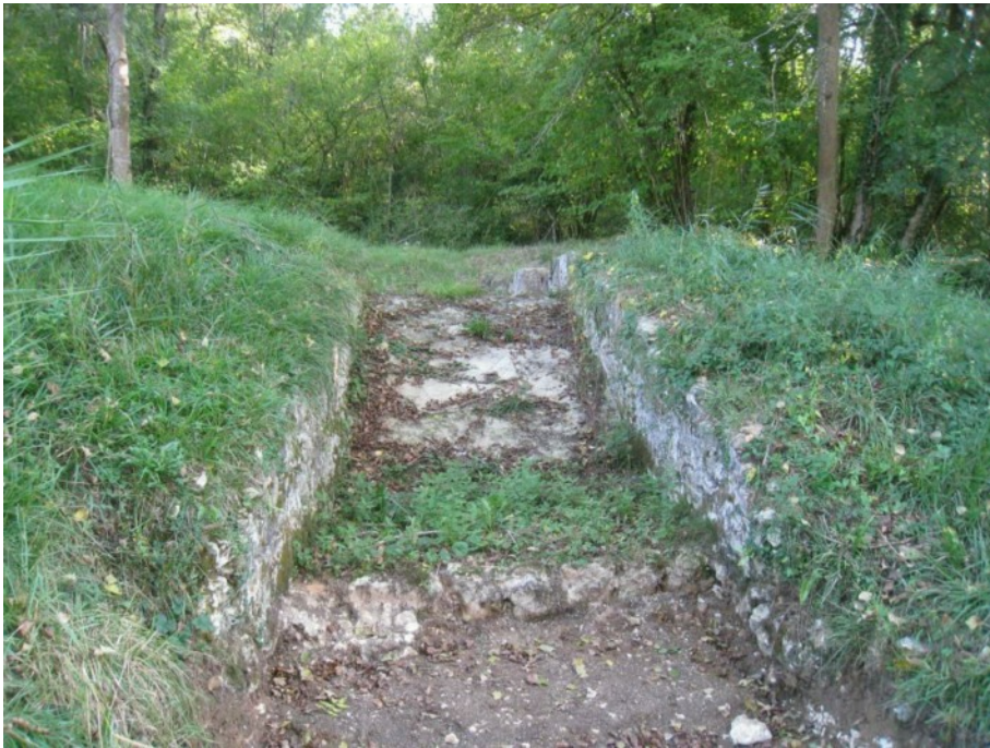
Coursier de l'évacuateur de crue
