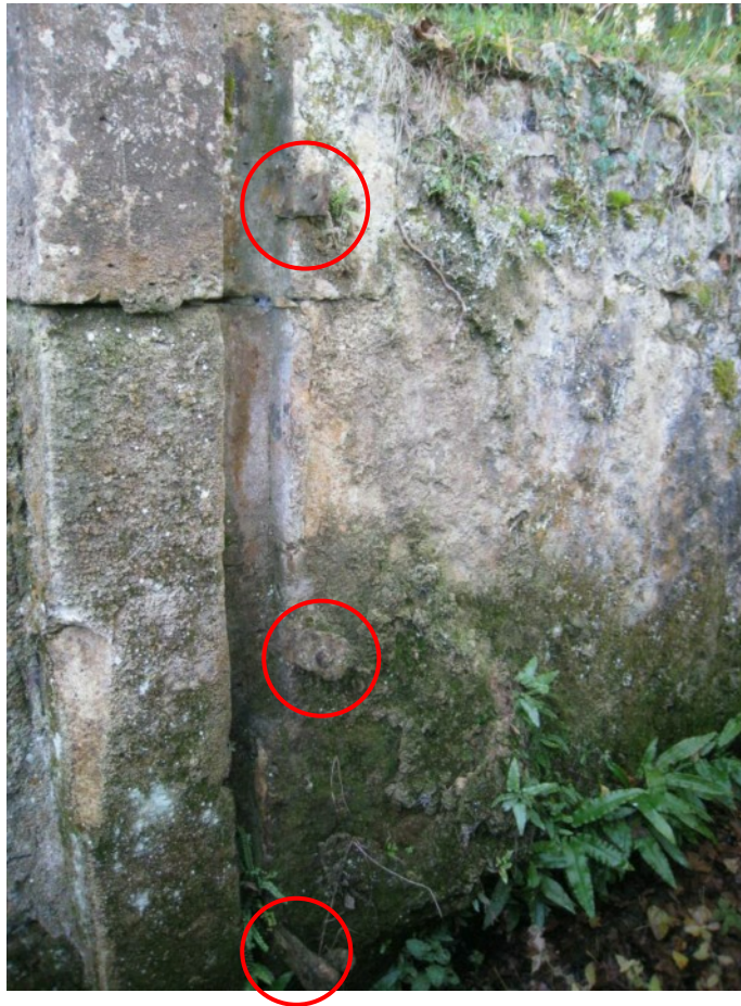
Rainure RG pour une vanne avec 3 pattes de fixation
