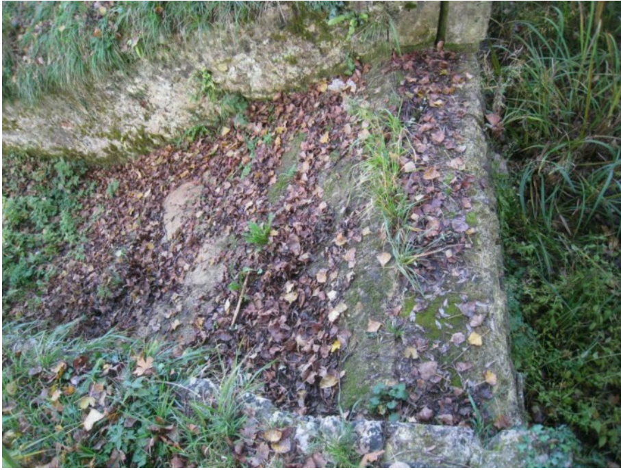
Seuil de l'évacuateur de crue
