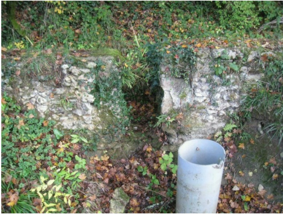
Vanne de contrôle du niveau dans le bief et siphon
