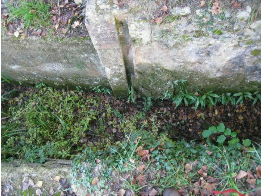
Canal vu de dessus (l'aval est à droite)
