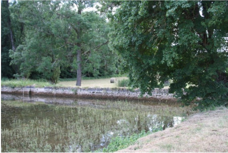
Retenue partiellement remplie le 27 mai 2011
