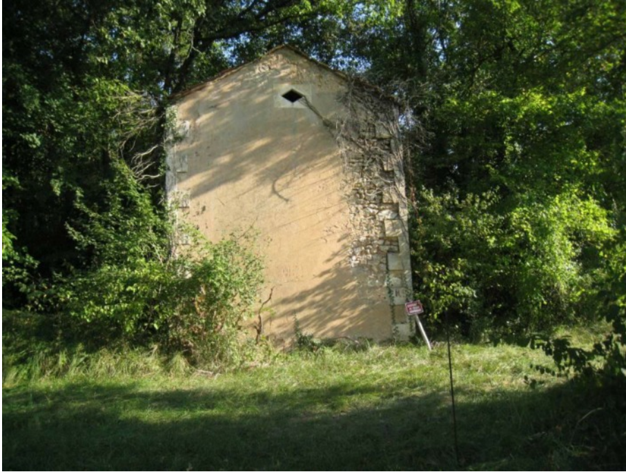
Local de la turbo pompe, sur le site du moulin Roux
