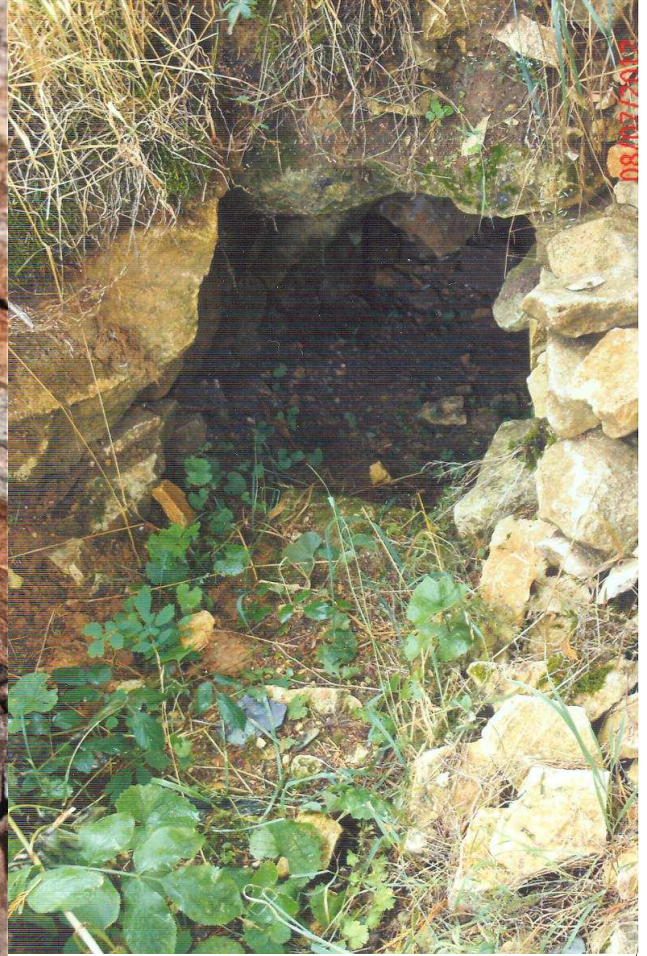
Ci-dessus Entrée actuelle de la galerie
